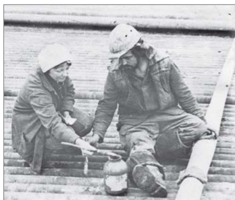
Маркировка испытательной колонны
