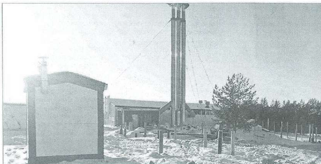
Новая котельная строится хорошими темпами
